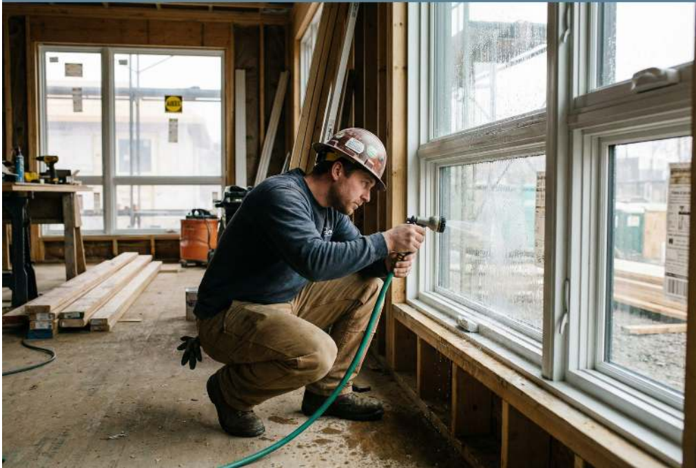
Test d'étanchéité sur fenêtre, durée de 10 minutes pour assurer la conformité
